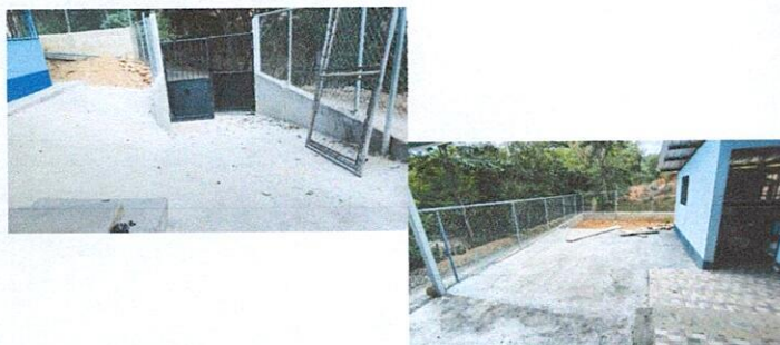
Foto 5: Mejoramiento de losa de patio y mejoramiento de cubierta de patio
