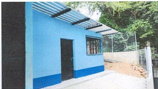
Foto1: Mejoramiento de estructura de aula tipo portico
