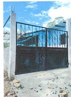
Foto 4: Sustitución de porton
