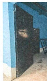
Foto 6: Sustitución de chapa del aula
