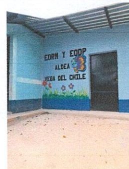
Foto 2: Mejoramiento de repello de aula tipo portico por ambos lados y mejoramiento de pintura
