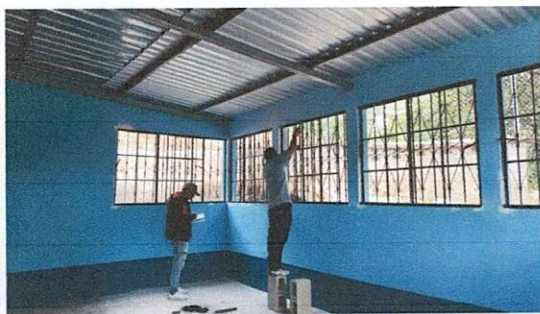
Foto 3: Fabricación e instalación de ventanas
